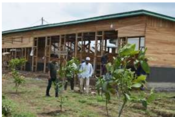
Gambar 3. Pembangunan 11 kios UMKM
